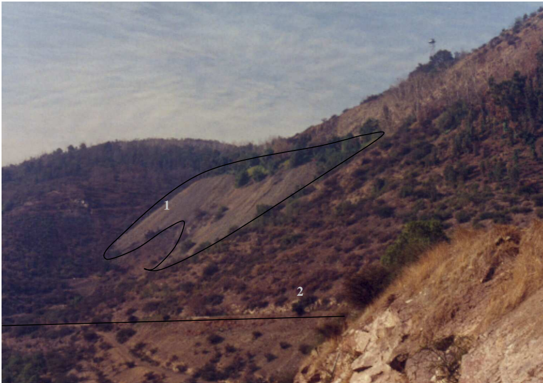
Fotografía n°5: Talud de rellenos (1) sobre el canal El Carmen. Se puede apreciar en la fotografía el nivel del canal (2).
